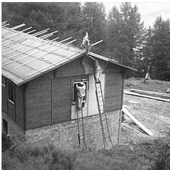
Travaux de couverture.
