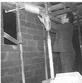
Travaux de spécialistes.
