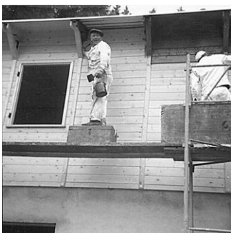
Travaux de peinture.
