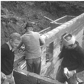
Travaux de maçonnerie.
