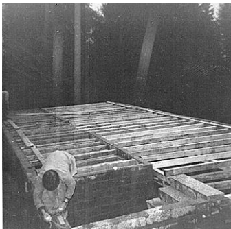
Travaux de ferrailage.
