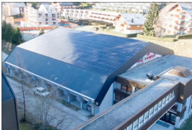
*Figure 3 Le toit de la halle de tennis du Régent, avec les panneaux photovoltaïques. La production du 80% de la consommation énergétique du Régent est visée.*
